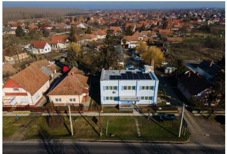
Szeghalmi Szakasztechnikus irodaépülete
